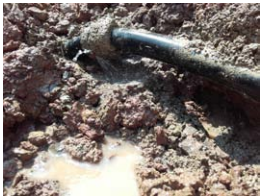
Ein Leckschaden kann hohe Kosten verursachen
