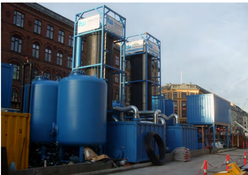
Eine Wasseraufbereitungsanlage im historischen Zentrum Kopenhagens
